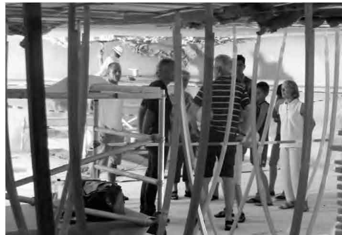
Flexible Abstützung der sichtbaren Decke.
